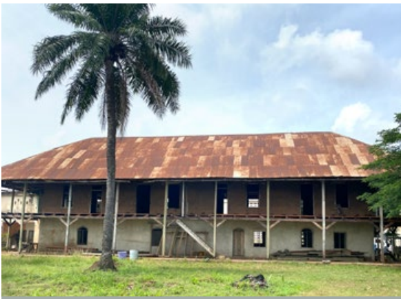
Von der Norddeutschen Mission erbautes Gebäude in Ho, Ghana
